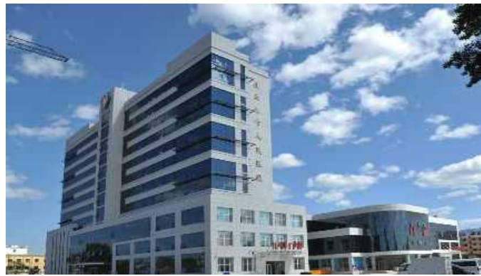
扎兰屯市医院 Zalantun Hospital
