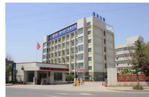
西安大普科技产业园
